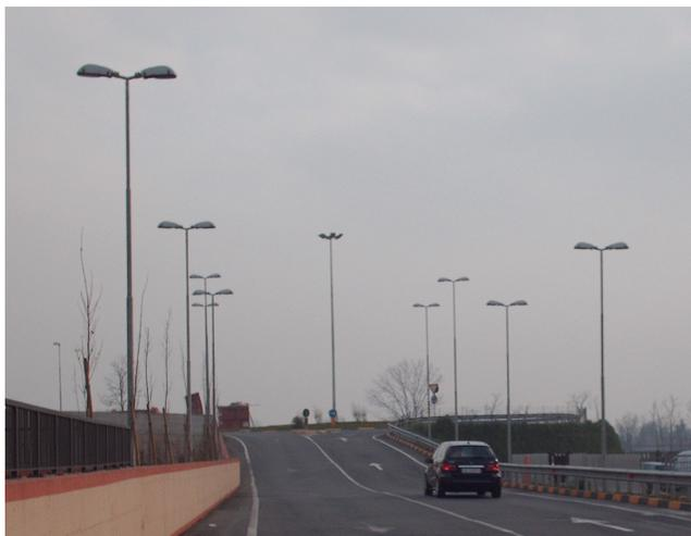
di mantenere l'installazione di apparecchi decorativi con ottica stradale totalmente schermata, fissati su palo ornamentale, ed equipaggiati con lampade ai vapori di sodio ad alta pressione con indice di Resa Cromatica  $Ra \geq 20$ , e Temperatura di colore pari a 2000K.
